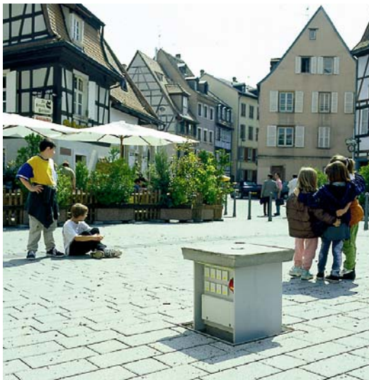
Auf öffentlichen Plätzen die Energie- und Medienversorgung gewährleisten...
