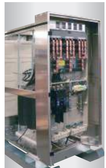
Abwärtstrafo: Vorder- und Rückseite, Eingang 1000V/Abgang 400V
